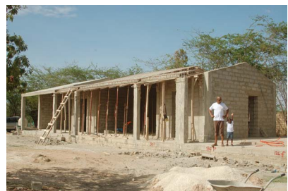
Vue partielle du bâtiment principal. Photo prise le 10/08/2014
